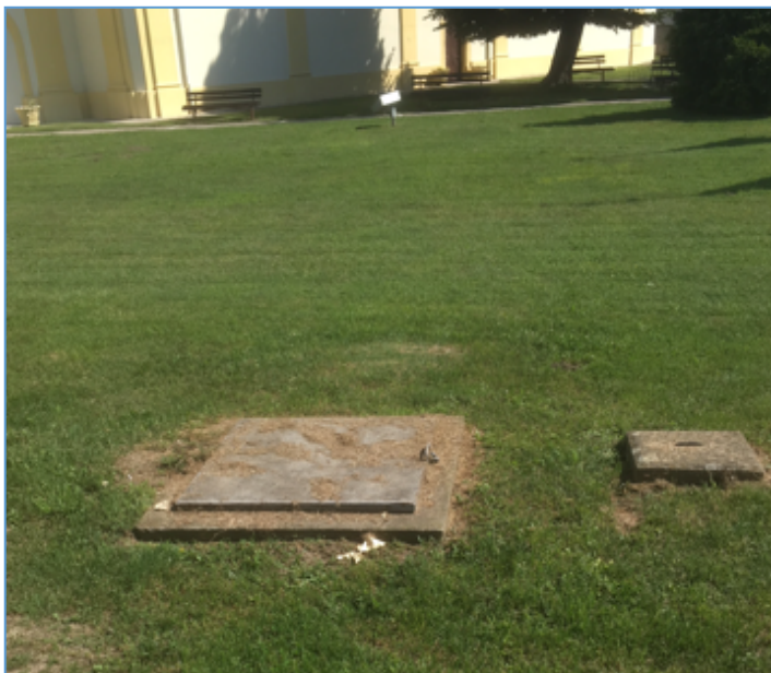
Слика 5. Деактивирани подземни танк за мазут у дворишту објекта (фото: С. Сушић)
