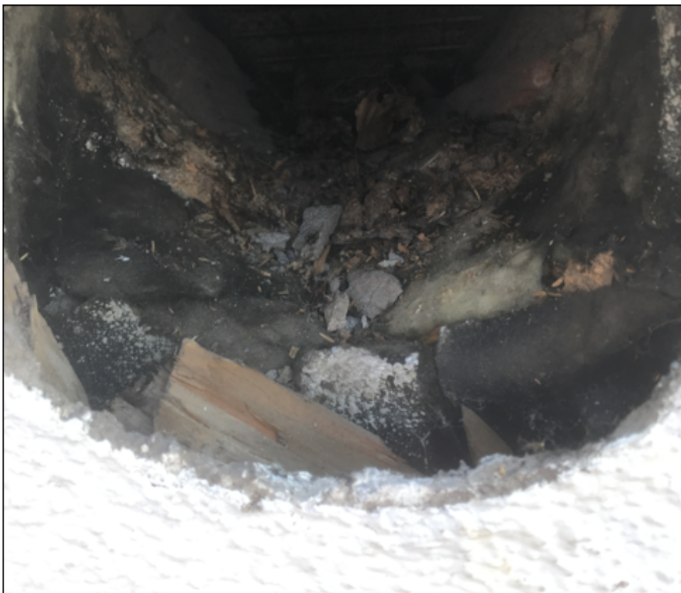
Слика 10. Отвор за вентилацију с попречним пресеком изолационе фасадне плоче која садржи азбест (фото: С. Сушић)
