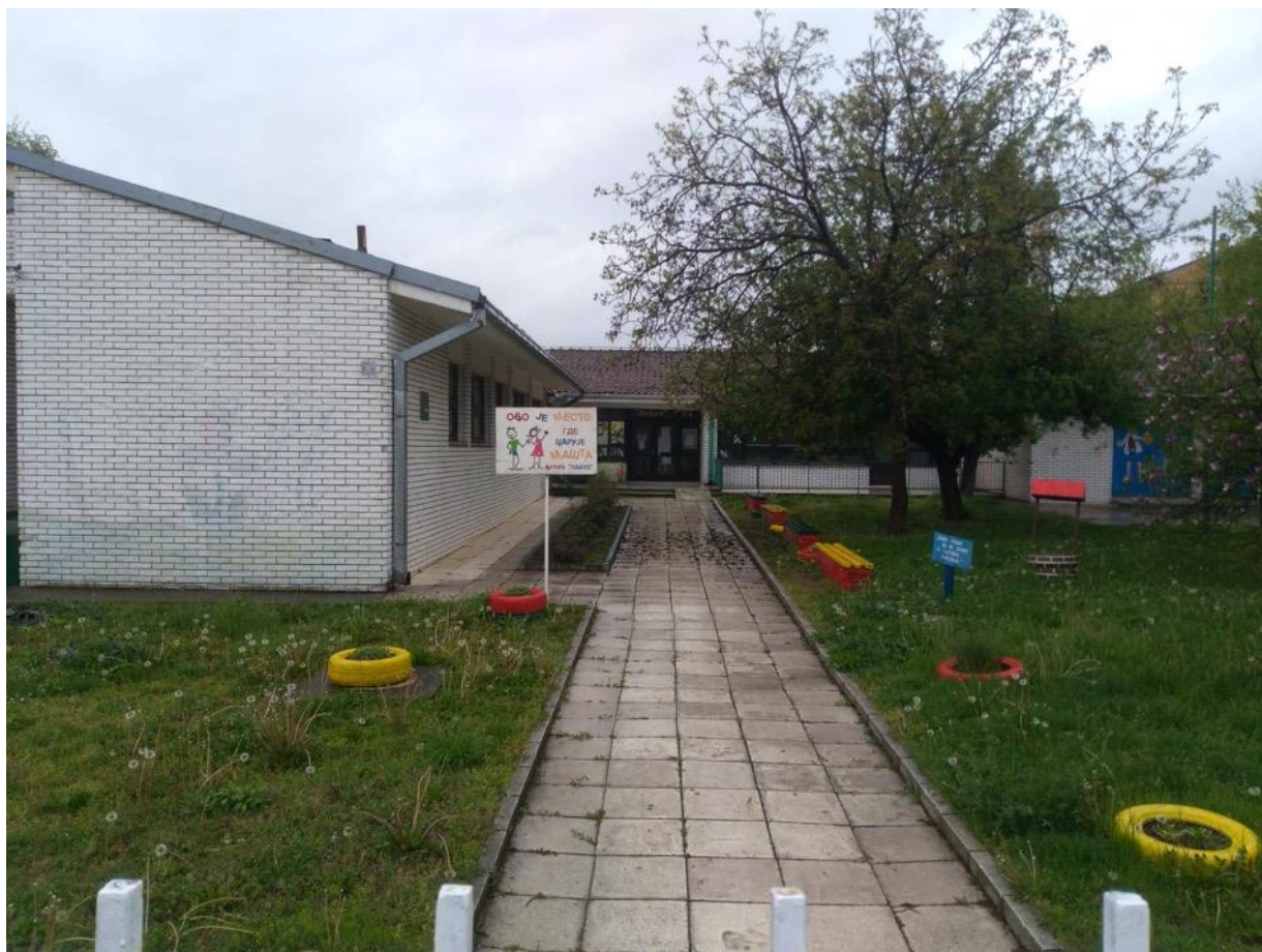
Slika 2 - Ulaz u postojeći objekat
