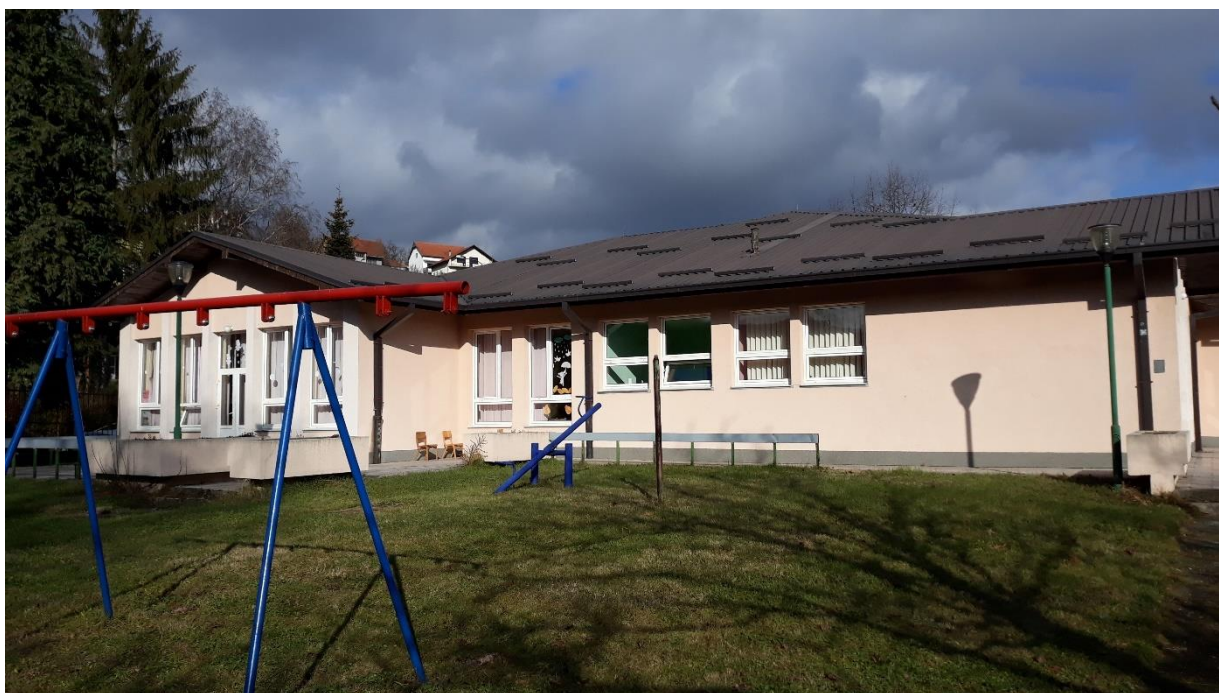
Slika 9 - Prikaz dela objekta na kome je planirana dogradnja
