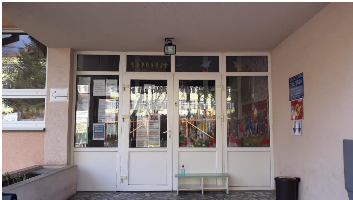
Slika 2 – Ulaz u postojeći objekat
