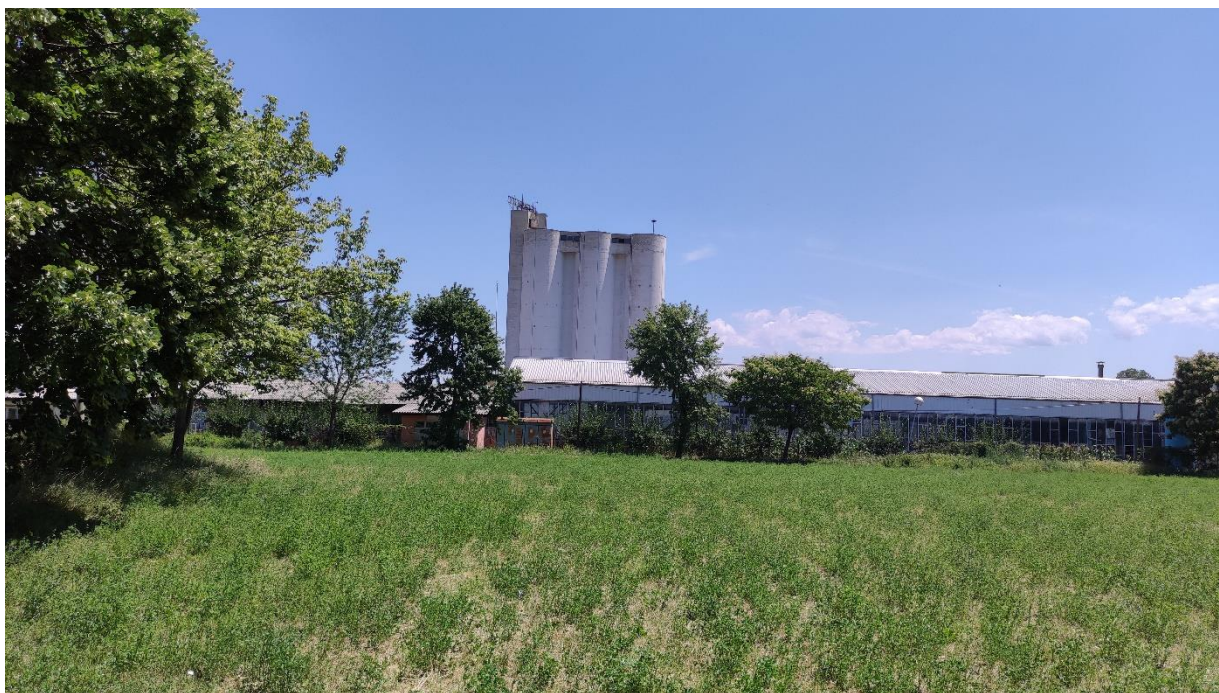
Slika 6 - Prikaz lokacije na kojoj je planirana izgradnja objekta
