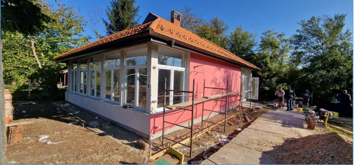
Slika 37. Spoljašnji izgled PU“Lane“ objekat Trnjane
