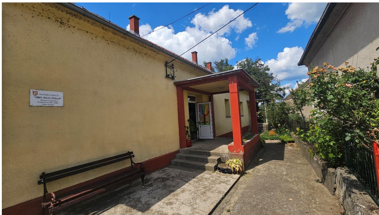
Slika 3. Ulaz u objekat koji će se renovirati
